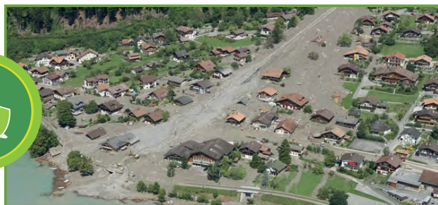
Une lave torrentielle se forme lors de fortes précipitations. De gros volumes d'eau s'écoulent en surface et entraînent des matériaux du sol.
