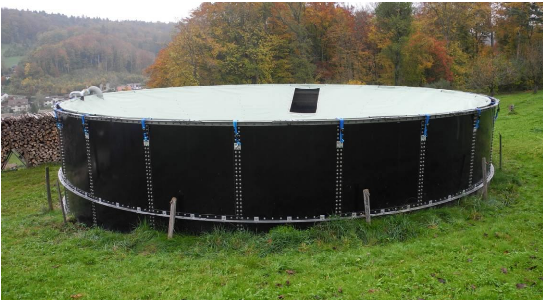
Abdeckung eines offenen Güllesilos mit einer Folie
