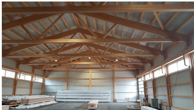
Äusserst schlankes Fachwerk inklusive Kranbahnen aus Hochleistungs-StabBuche in der neu gebauten Fertigwarenhalle am Standort Les Breuleux.
